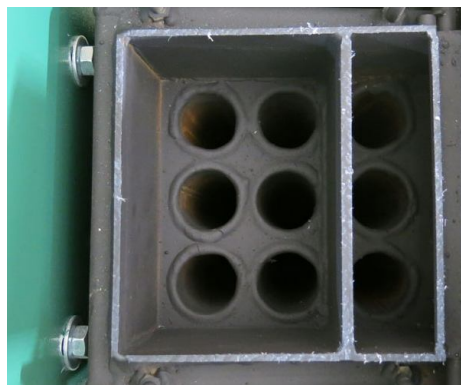
Рис. 8 - Доступ к прочистной крышке теплообменника
